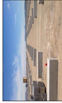
Longrines en béton
